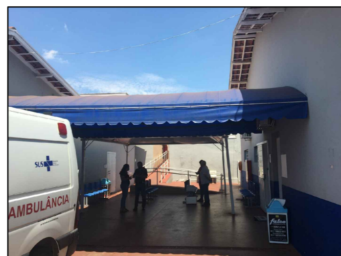
IMAGEM DO LOCAL A SER INSTALADA A COBERTURA
